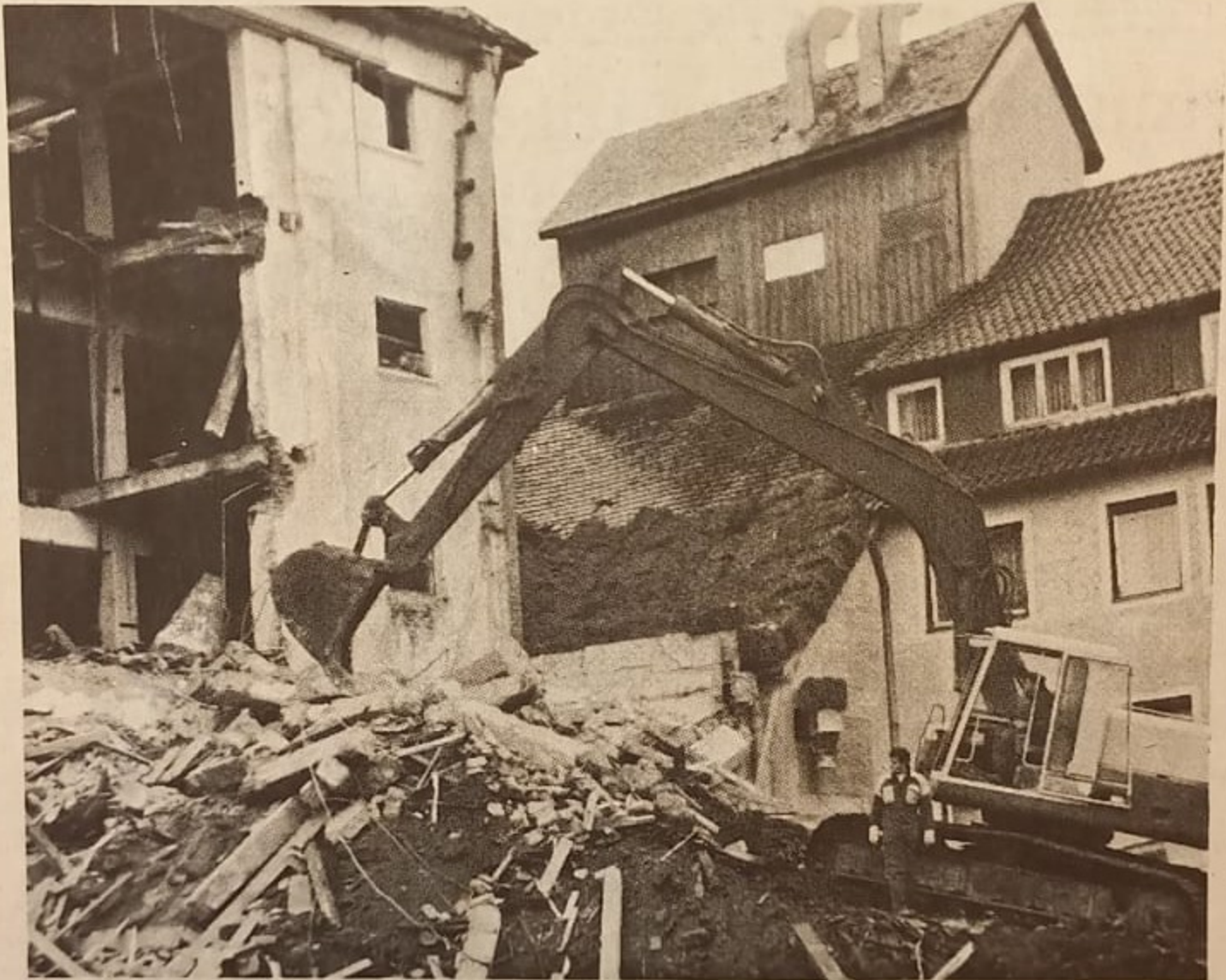
Selbst am Sonntag arbeitete der Bagger an der einstigen „BAG“. Das umgebende Straßenstück war abgesperrt. Foto: Weih
