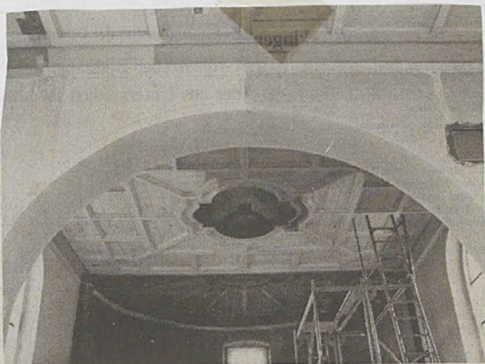
Blick auf den Chorbogen und den Chorbereich der Rupertshofer Pfarrkirche; der halbrunde, dunkle Teil im Hintergrund war früher der Deckenbereich der hier „eingeschobenen“ Sakristei; diese hat jetzt rechts vom Kirchenschiff einen eigenen Raum erhalten. Foto: vf
